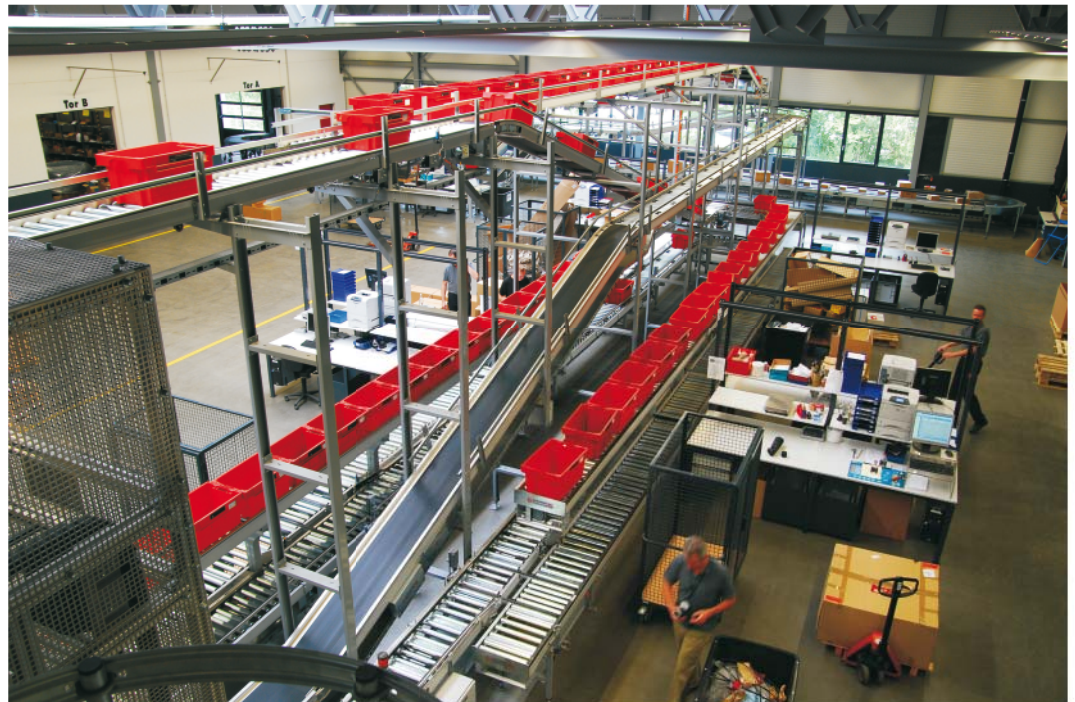
Die Förderleistung der Materialfluss-Anlage im Reiff-Logistikzentrum in Reutlingen ist auf 800 Behälter pro Stunde bei einer Geschwindigkeit von 0,5 m/s ausgelegt
